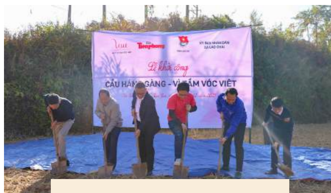
Khởi công xây dựng cầu dân sinh Háng Gàng - Vì Tâm Vóc Việt tại bản Háng Gàng, xã Lao Chải, tỉnh Lào Cai.
